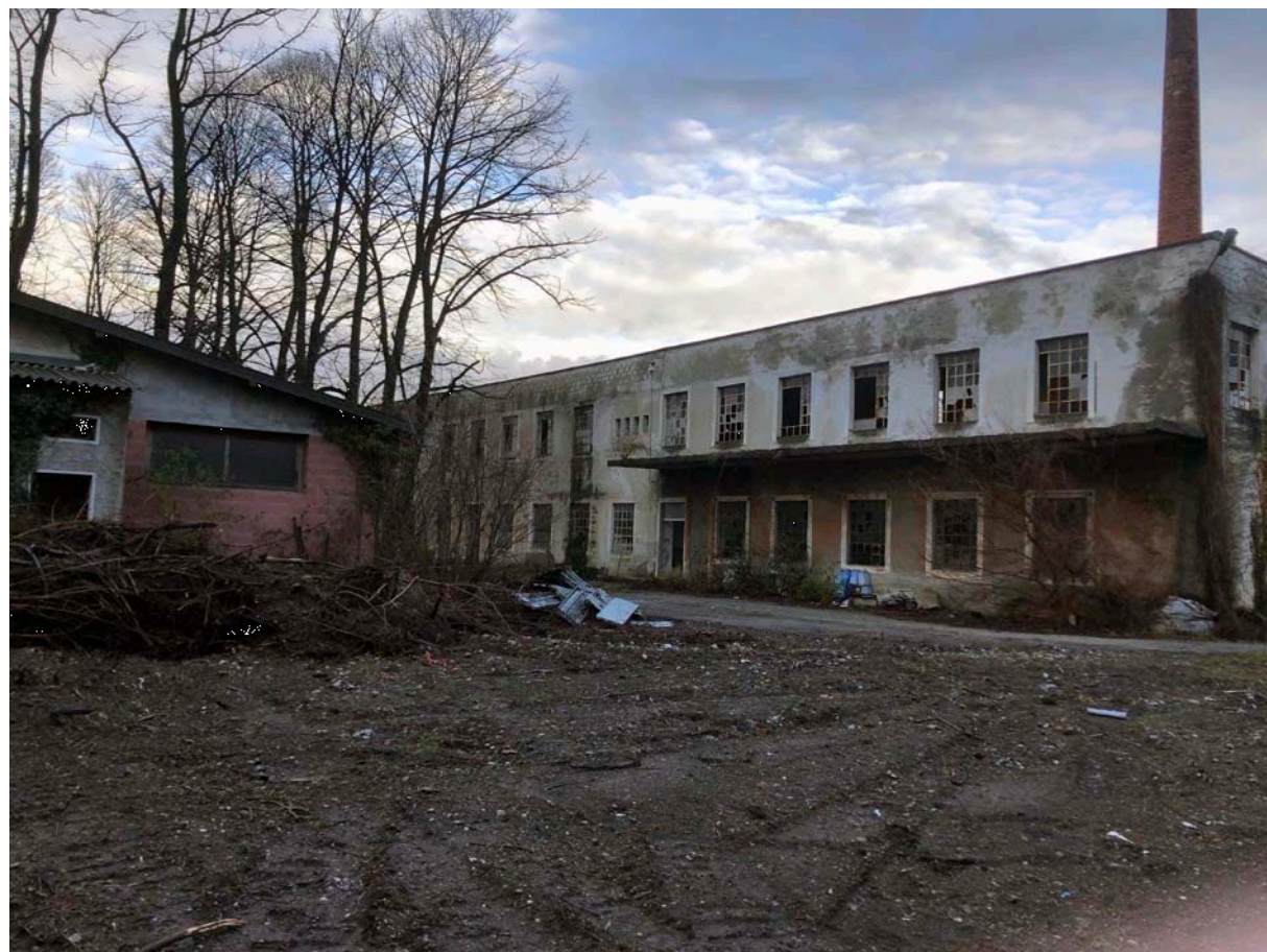
FOTO EDIFICIO PRINCIPALE DA SUD
