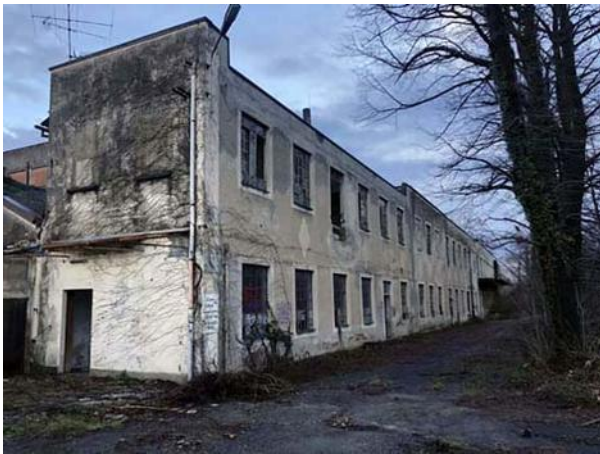
VISTA FABBRICATI ESISTENTI
