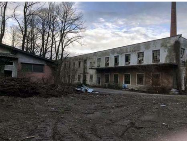
VISTA FABBRICATI ESISTENTI
