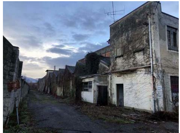
VISTA FABBRICATI ESISTENTI
