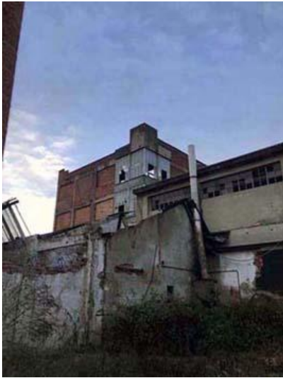
VISTA FABBRICATI ESISTENTI
