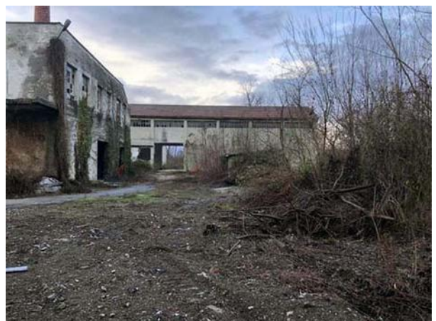
VISTA FABBRICATI ESISTENTI
