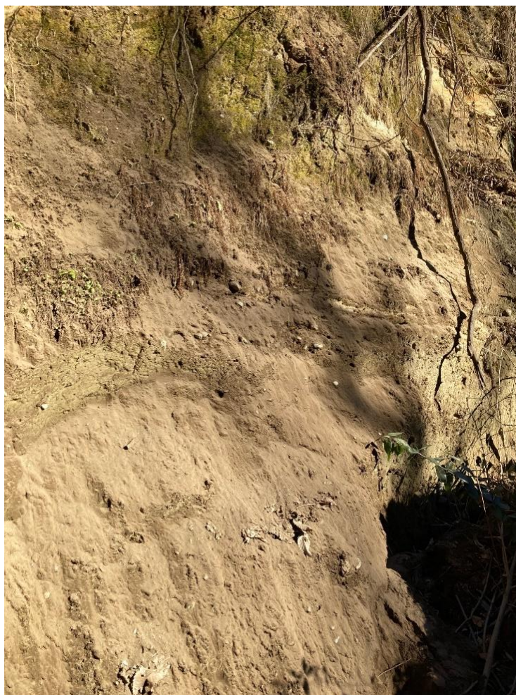
Figura 2 - Particolare del terreno esposto all'interno della frana. Trattasi di accumuli sabbiosi altamente erodibili che caratterizzano i versanti che insistono sulla Roggia Zinesco
